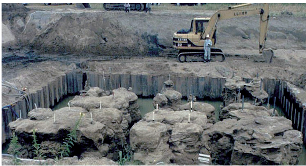
実験の実施状況（地盤注入開発機構提供、1999年撮影）
